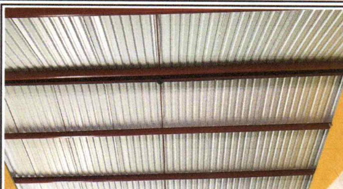
Foto 2: CUBIERTA DE LÁMINA INSTALADA
