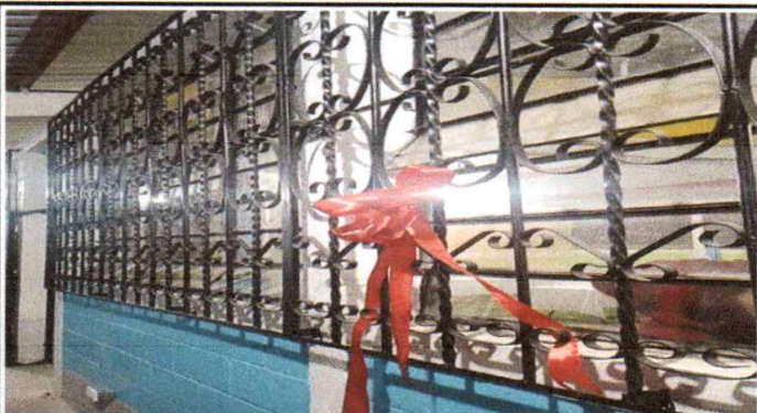
Foto 3: VALCONES INSTALADOS EN VENTANAS
