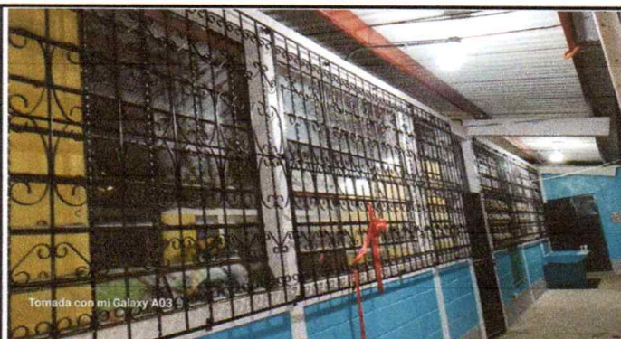
Foto 4: VALCONES INSTALADOS EN VENTANAS
