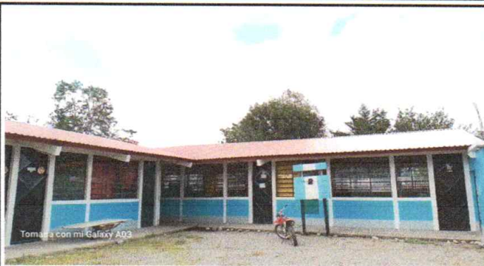
Foto 1: CUBIERTA DE LÁMINA INSTALADA
